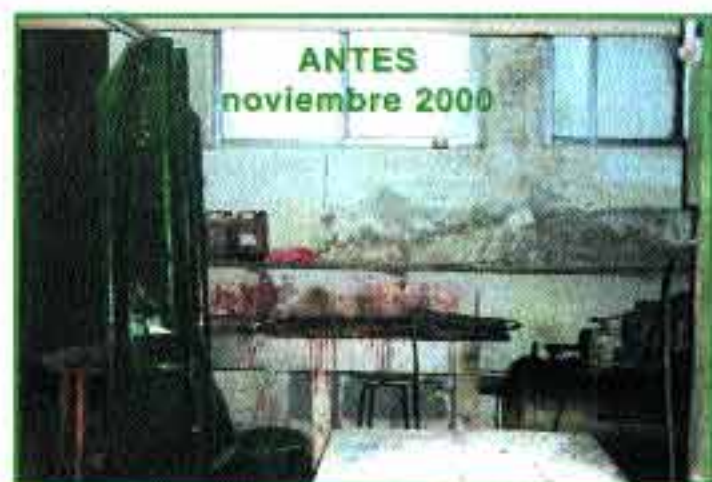
Cabina barnizado de cortina de agua.
