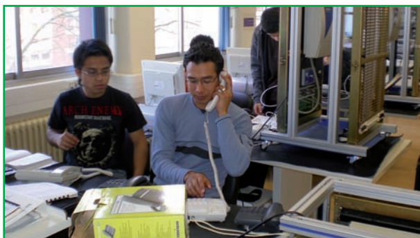
Realizando pruebas tras programación con PABX
