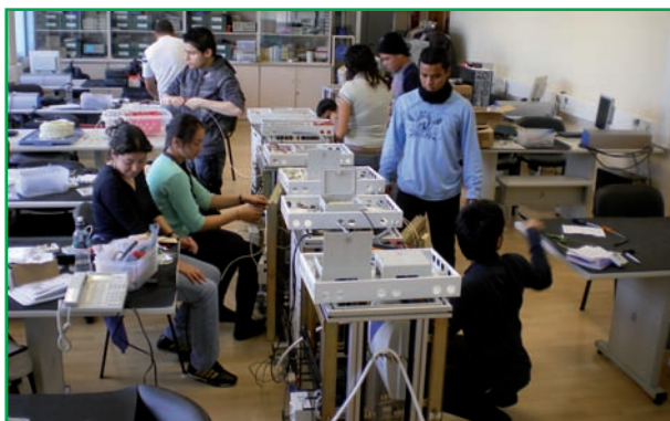
Realizando el montaje de una instalación de telefonía según el reglamento de la ICT.
